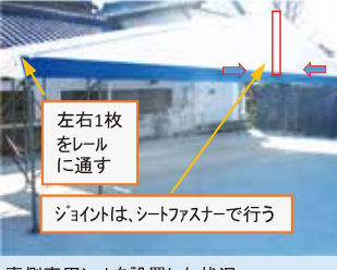
妻側専用シートを設置した状況。(写真は、2分割タイプ)
