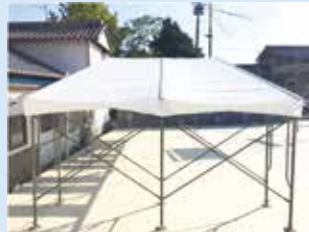
2スパン分の専用屋根シートを設置した状態。(側面側)
