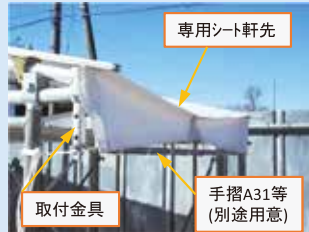
軒先の専用シート取付け状況。(外部)
