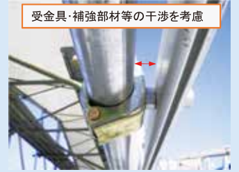
妻側専用レールを、トラス材の下弦材に取付けた状態。(横から)
