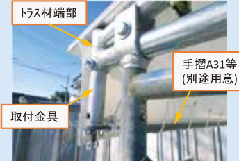
軒先側の端部シート取付金具設置状況。
