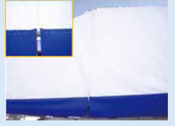
左右からの妻面シートをファスターを合せてジョイントする。(写真は、2分割タイプ)
