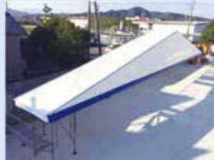
1スパン間に屋根専用シートと妻側専用シートを設置した状態。
