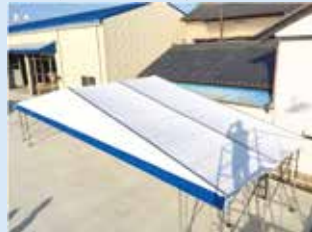
2スパン分の屋根専用シートと妻側専用シートを設置した状態。(正面側)
