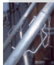
調節は上部内管と下部外管をスライドさせ、ピン穴にハンドルピンを差し込んで行います。微調節はハンドルピンを回転させて行います。
